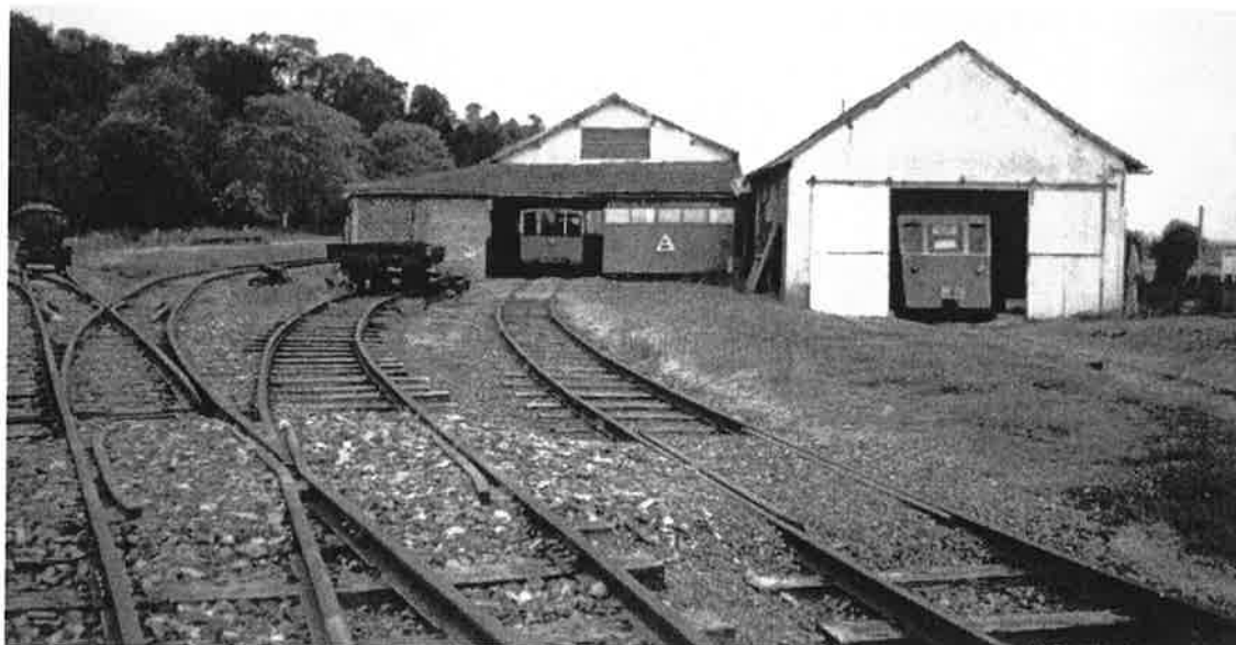
Détail du faisceau à voies métriques du dépôt des Amis des Chemins de Fer des Côtes du Nord. A l'extrême gauche : un wagonnet. Devant la remise de gauche un wagon plat. Deux locotracteurs montrent le bout du nez à l'entrée de chaque bâtiment (photo Liliane Braibant).
