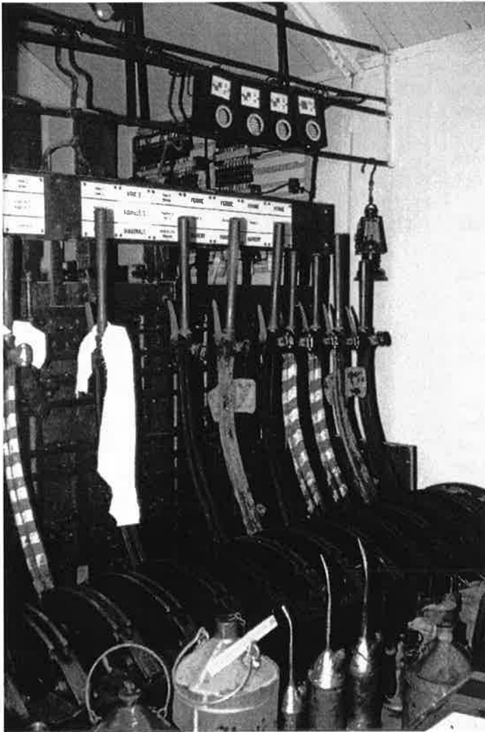
Le poste de commande d'aiguillages Vignier de 1889 (photo Didier Delfosso).
