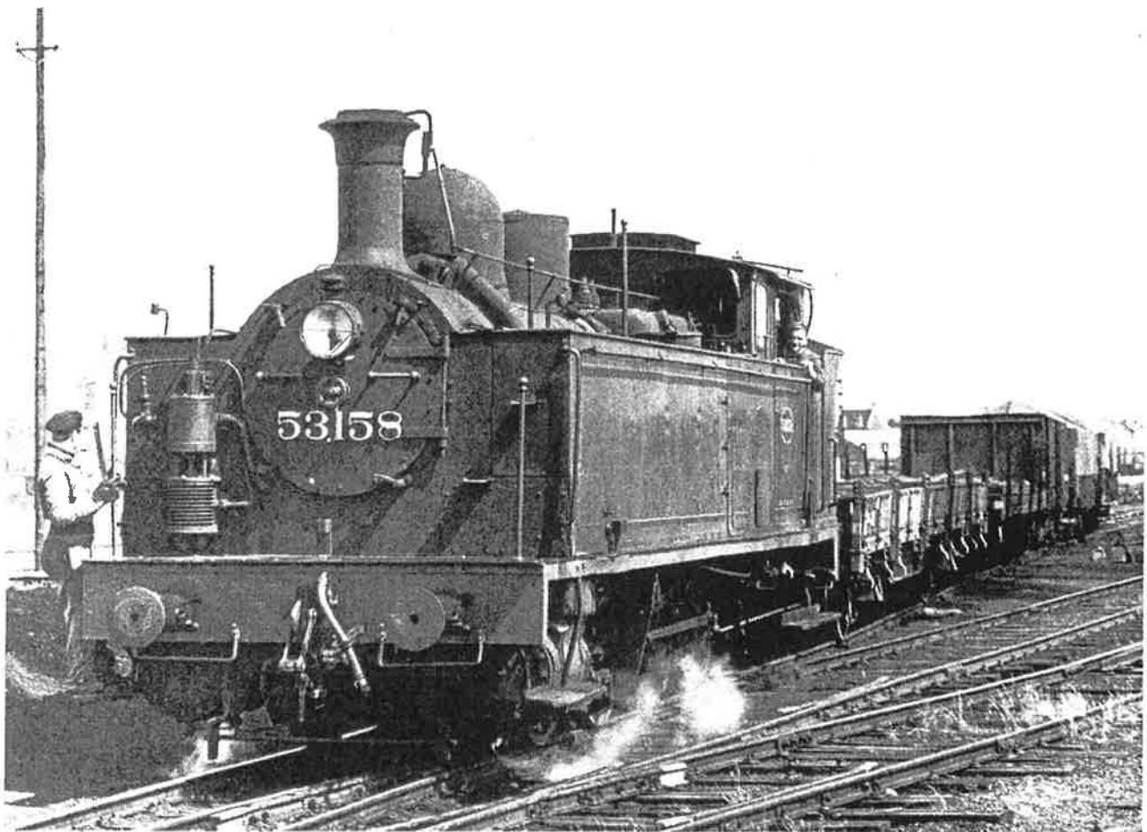
Locomotive de manoeuvres type 53, numéro 53.158, photographiée à la butte d'Antwerpen-Zuid par G. Delise. Document publié dans «Vapeur en Belgique» tome 1 de Phil Dambly. Construites avant la première guerre, les dernières ont été mises hors-écritures en 1966. La type 53 (ex-type 23) : soixante ans de bons et loyaux services dans toutes les gares de triage du pays.
